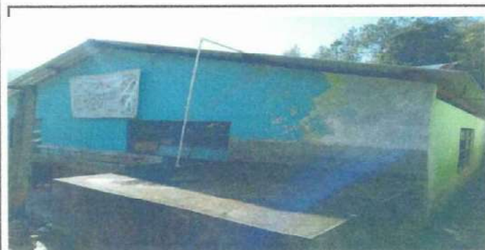
Foto 5: se observa la presencia de humedad avanzada en pared detrás en el modulo I.
